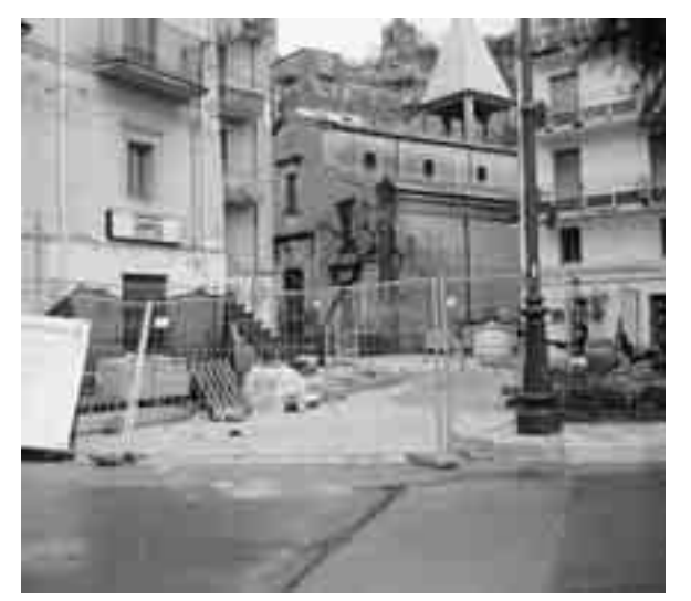
TORTORICI, IL CANTIERE IN PIAZZA FARANDA
