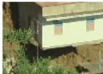
A villaggio Pezzolo una palazzina di recente costruzione è rimasta senza terreno sotto una parte delle fondamenta. Sopralluoghi tecnici in corso per decidere le modalità di intervento
